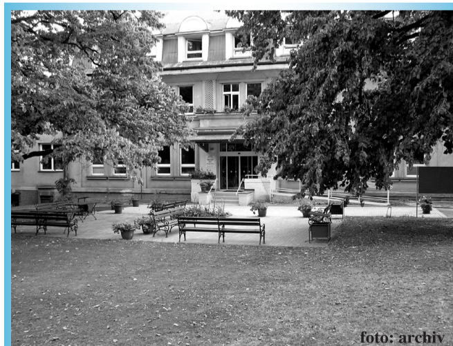
Celkový pohled na budovu trebotovské nemocnice
