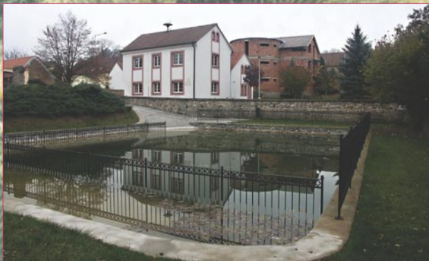
Knihovna (současný pohled z Cementářské ulice)
