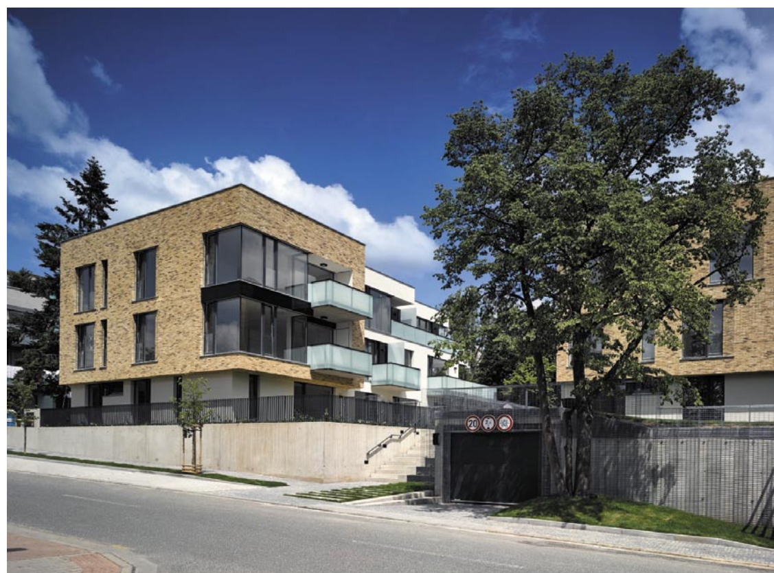
Residence Černošice: viladomy Františka a Emilie v Černošicích. Výherce prestižní soutěže Best of Realty 2016 v kategorii rezidenčních projektů do 25 bytů.
