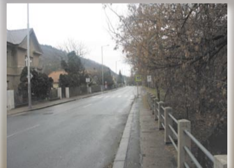
I TRASA 256 ZAZNAMENÁVÁ NYNÍ DROBNOU ÚPRAVU, V RADOTÍNĚ SE TO VŠAK NIJAK NEODRÁŽÍ
